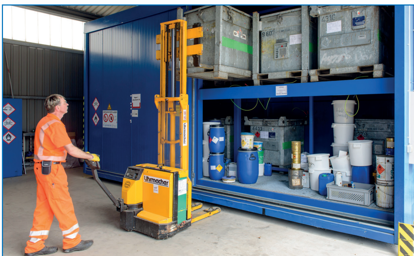
Regale im Problemstoff-Zwischenlager
